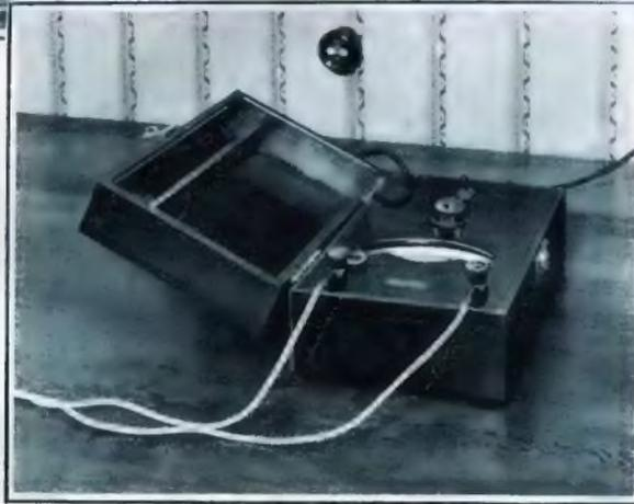
Abb. 1. Das Netzanschluß-Röhrenvoltmeter von Nadir, gebaut nach den Angaben des Verfassers.
